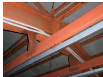
(例)クオリティーチャンネルは支持材と同方向に取付
