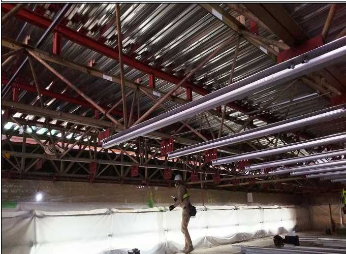
CPS工法: オープンスペース・ストッパー取付状況
