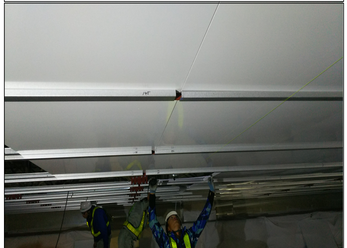
CPS工法: 軽量天井金属パネル挿入状況
