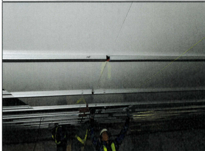
CPS工法: 軽量天井金属パネル挿入状況
