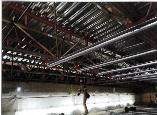
CPS工法: オープンスペーサー・ストッパー取付状況
